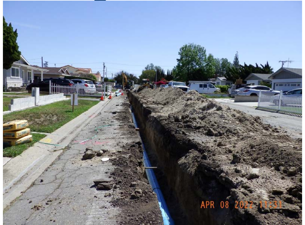
Sustitución de la Tubería Principal de Agua Alwood Ave- Anthony Ave [4.200 pl (1280 ml)]
